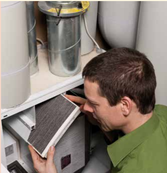
Filterwechsel an der Lüftungsanlage
