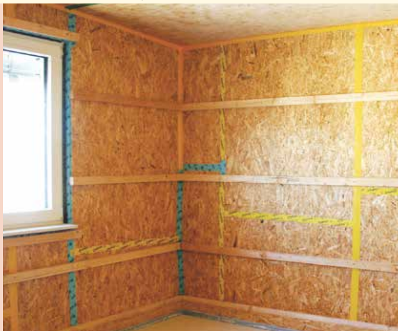
Luftdicht verbundene Holzwerkstoffplatten
