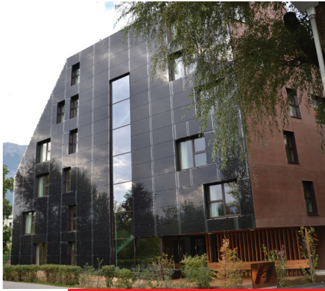
Forschungsprojekt Wohnanlage An-der-Lan-Straße 16 Fassadenintegrierte PV-Anlage mit Batteriespeicher und einem Flatrate-Modell
