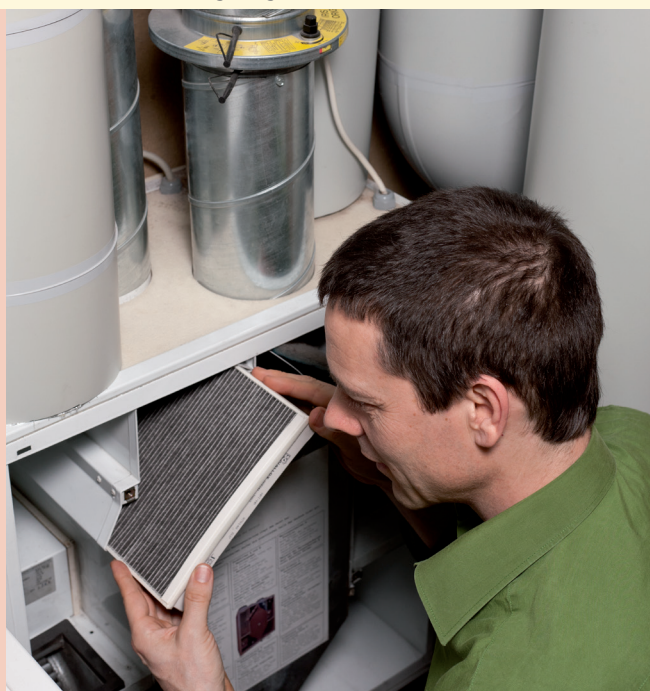
Filterwechsel an der Lüftungsanlage
