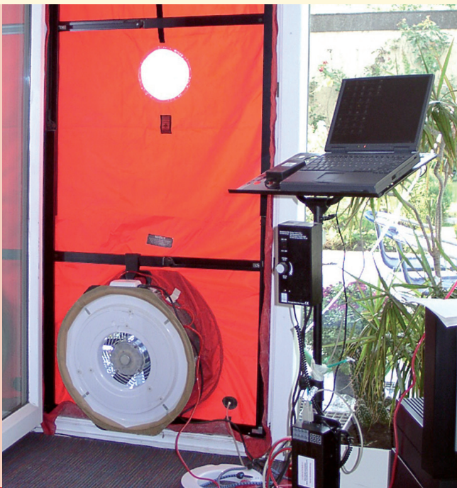
Ventilator zur Durchführung eines Drucktests
